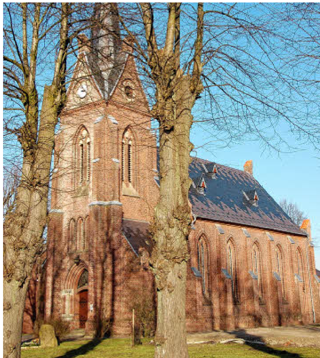
Die St. Anskar-Kirche hat ein neues Dach bekommen – die grau-rote Schiefereindeckung ist aus Mitteln der Denkmalpflege bezuschusst worden. H. SCHWICHTENBERG
